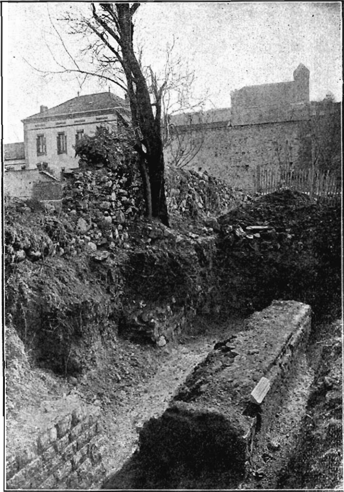
PLATE-FORME D'UN TROPHÉE (Chantier Baron).
