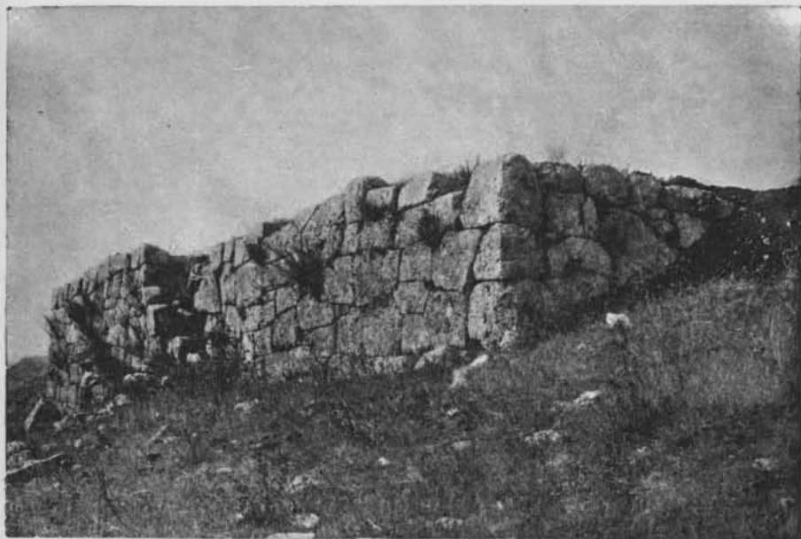
1. Sostruzione di una terrazza prossima al tempio di Giunone Lucina.
