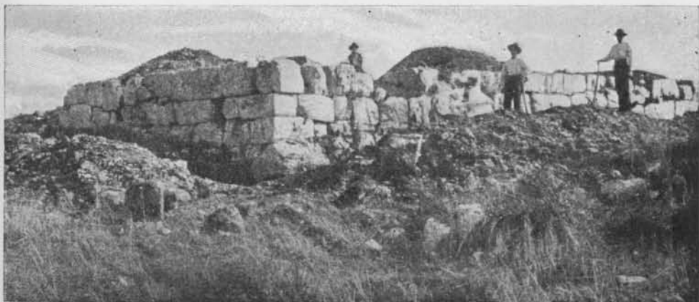
2. Uno dei templi (n. 12) sull'acropoli minore durante lo scavo.
