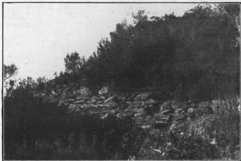
Fig. 1. — Mur en arête de poisson, à Saint-Estève-d'Hyères (Var).
