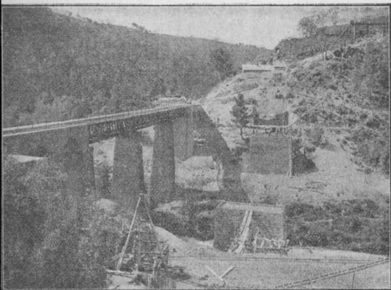
Construction d'un viaduc sur la ligne de l'Ouenza
