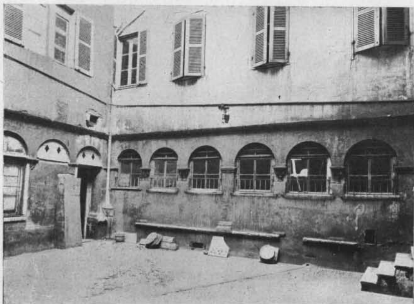
La cour du cloître avant sa restauration. On aperçoit très nettement, entre les fenêtres, les chapiteaux des colonnes et, plus bas, la banquette de support.
