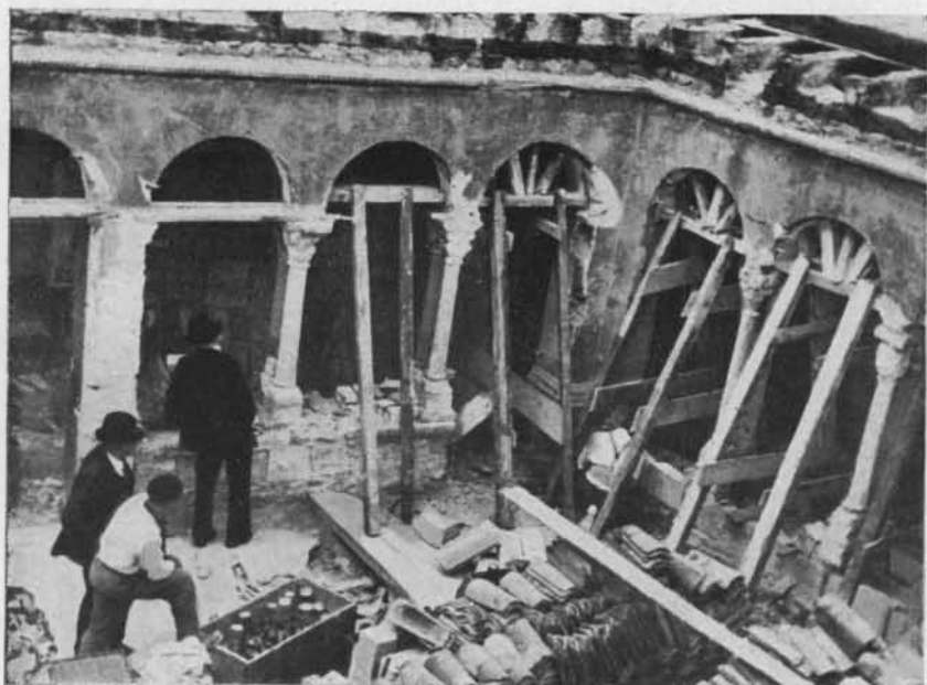
Le cloître pendant les travaux de restauration
