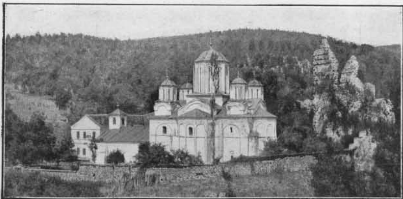
Fig. 35. — Église de Ravanitza avec les ruines de son rempart : vue générale (d'après la Serbie illustrée ).
