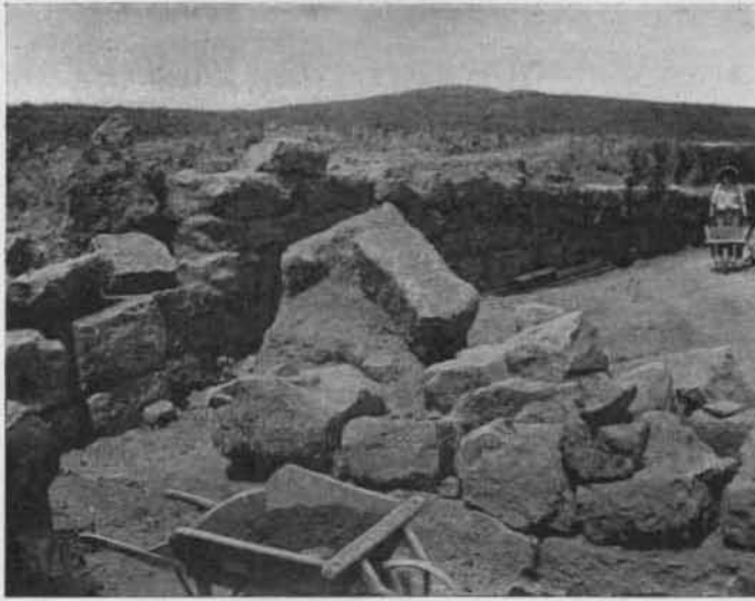
Fig. 14. — Carrer que dava a la porta, ab el mur de contenció del terraplè superior vist desde la muralla. (Fot. Gandia)
