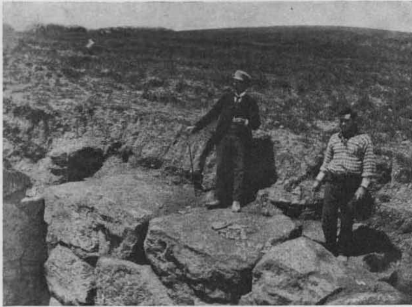
Fig. 7. — Part superior de la torre de la figura anterior. (Fot. Cazorro.)
