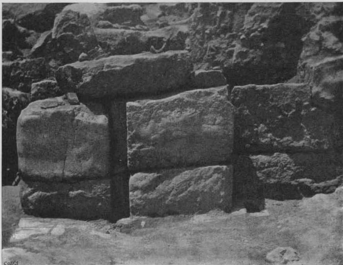
Fig. 8. — Disposició d'un dels brancals de la porta d'Empuries ab la regata de la reixa corredera y la polleguera de les portes.
