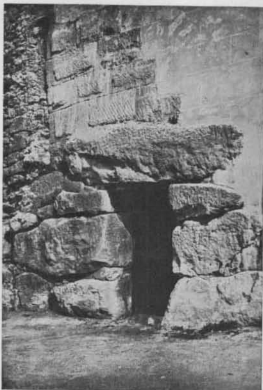
Fig. 28. — Porta de les muralles de Tarragona ab la superposició dels aparells.
