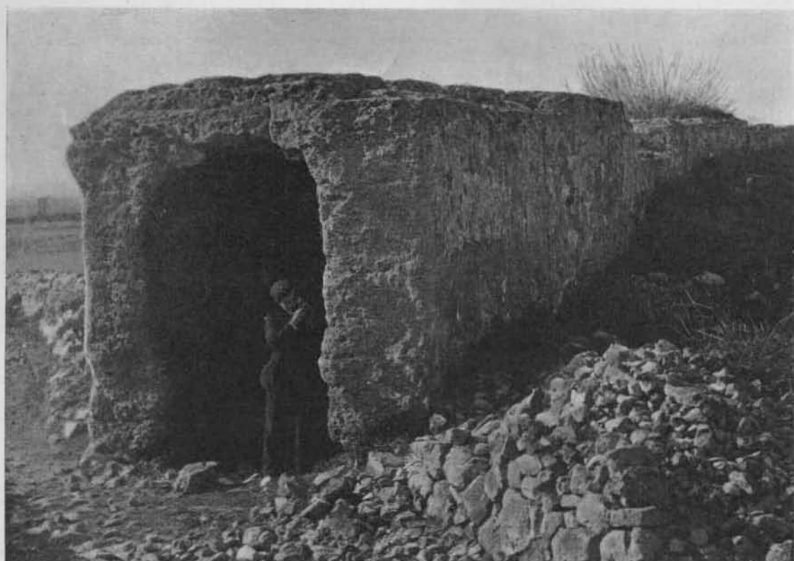
Fig. 44. — Muralla de formigó del recinte romà d'Empuries.
