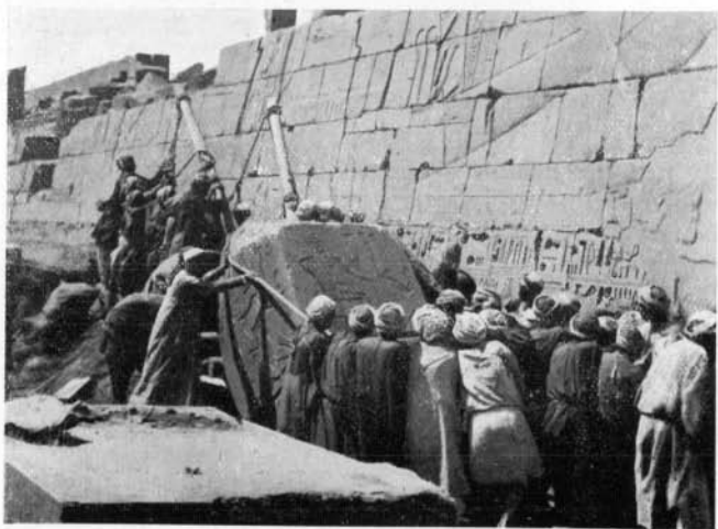
KARNAK. Les travaux de restauration (p. 150).
