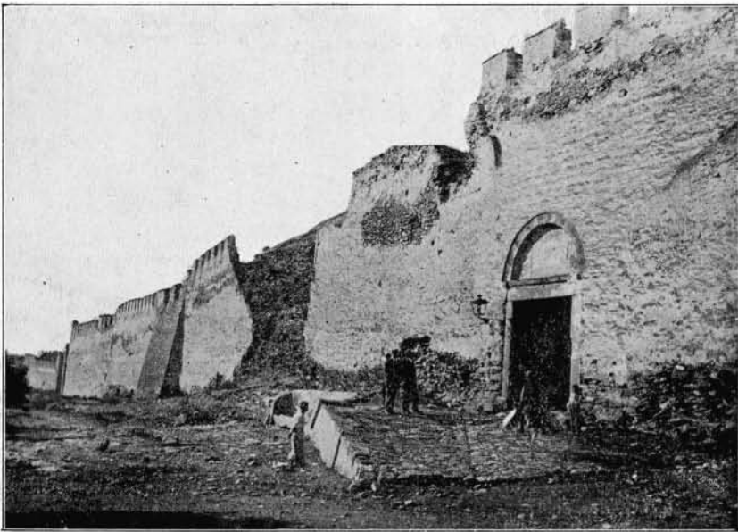
2. Le même mur avec l'entrée actuelle.
