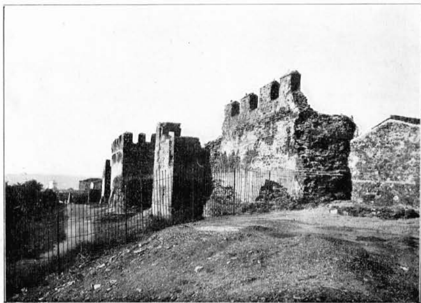
1. Le mur oriental.
