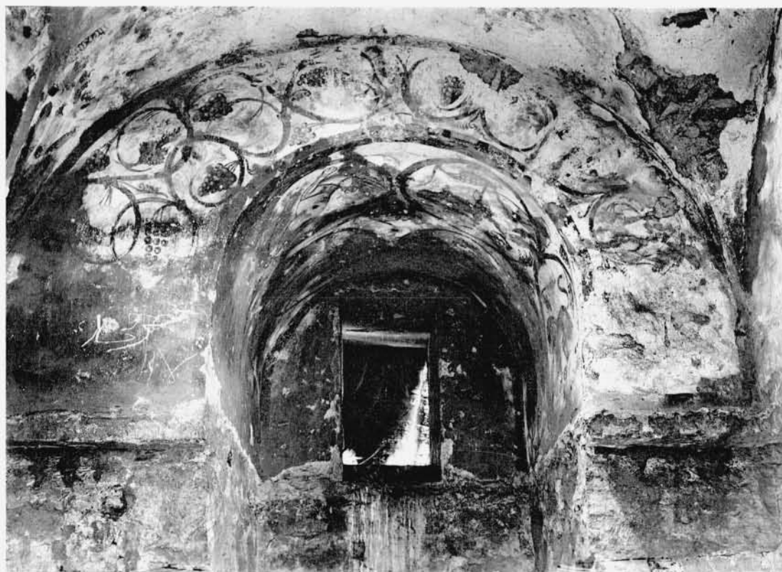
2. — QEŞEİR ÂMRA. - Salle E. - Décoration de l'alcôve au Nord de la salle.
