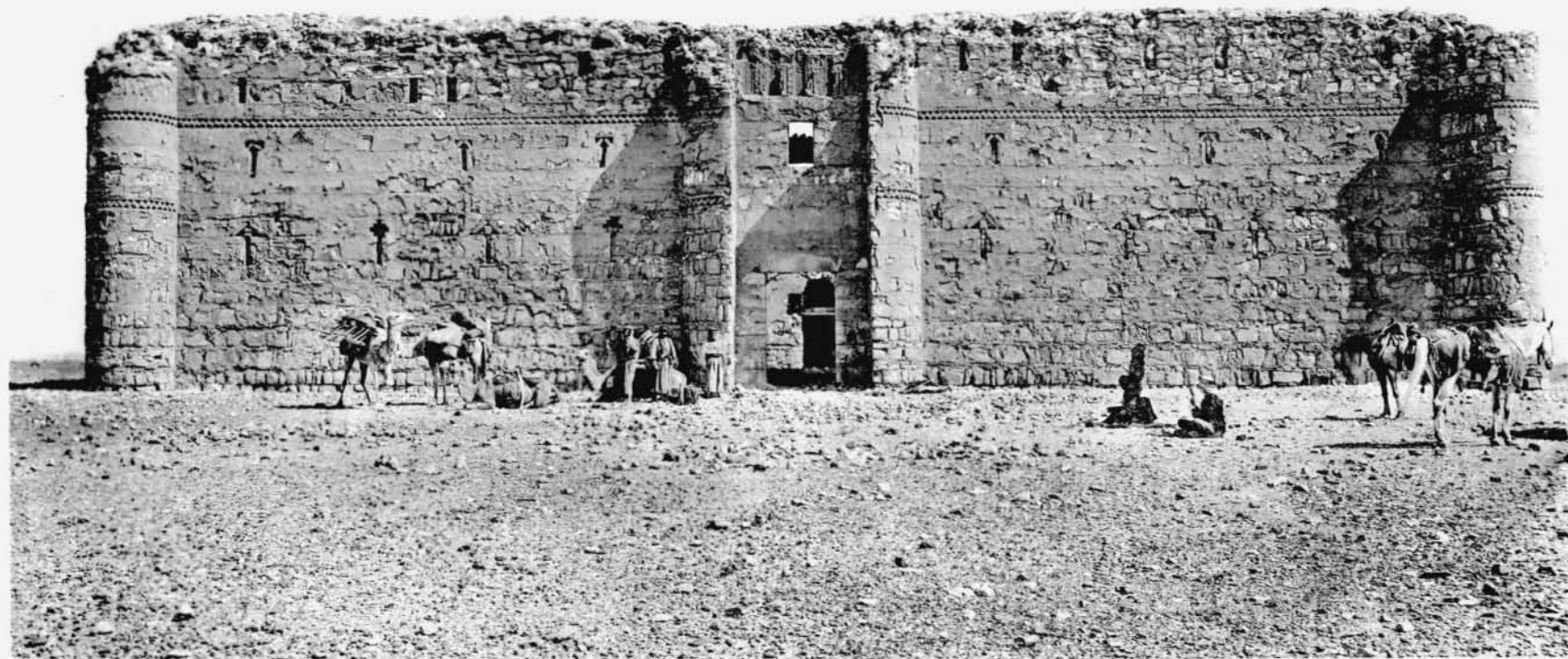
QASR HARÂNEH. - La Façade du château (Sud).
