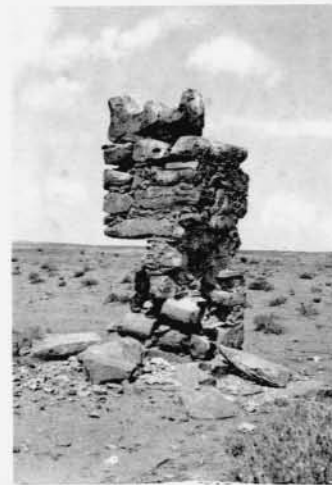
5. — QEŞEİR ĀMRA. - Pilier au S.-E. du château.
