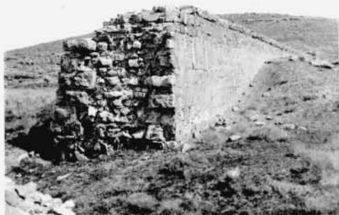
2. — QANÂTIR ES-SAKER. - Digue rompue.
