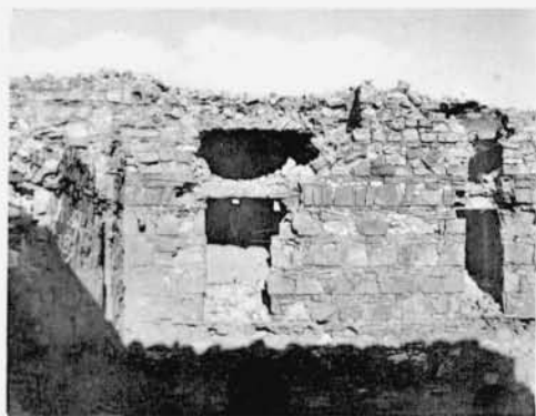
3. — QASR-ĤARÂNEH. - Porte de 37; bout de poutre accolée au linteau.
