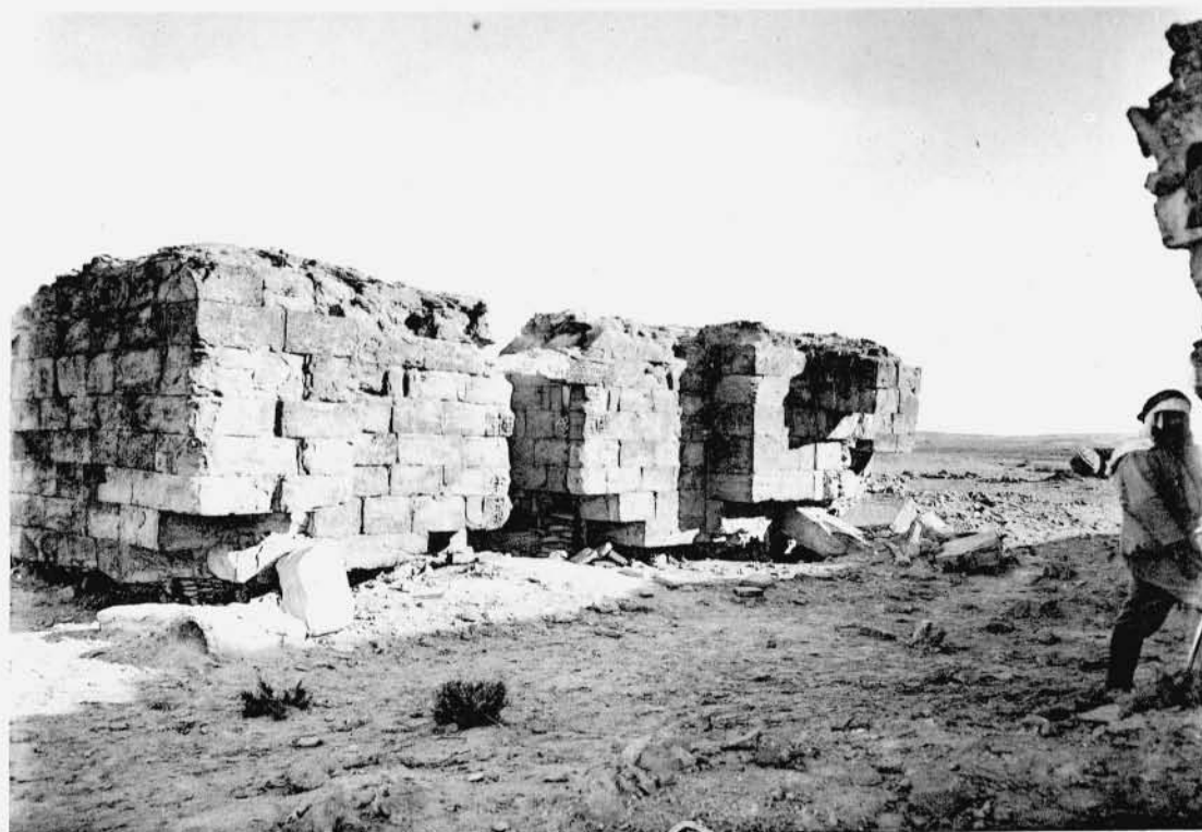
2. — QASR ET-ṬŪBA. — Chambre B' vue de l'Ouest et jambage oriental de la grande porte C.
