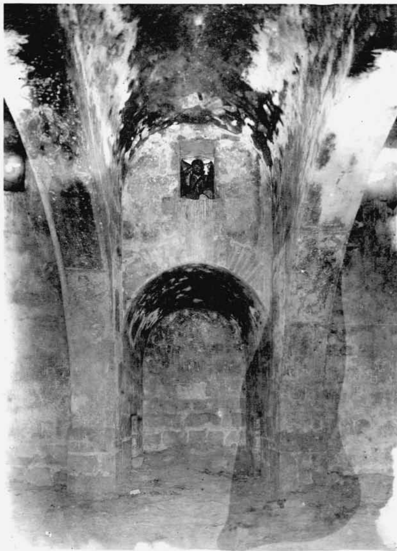
1. — QEŞEİR ĀMRA. - Salle A, vue prise sur la porte d'entrée.
