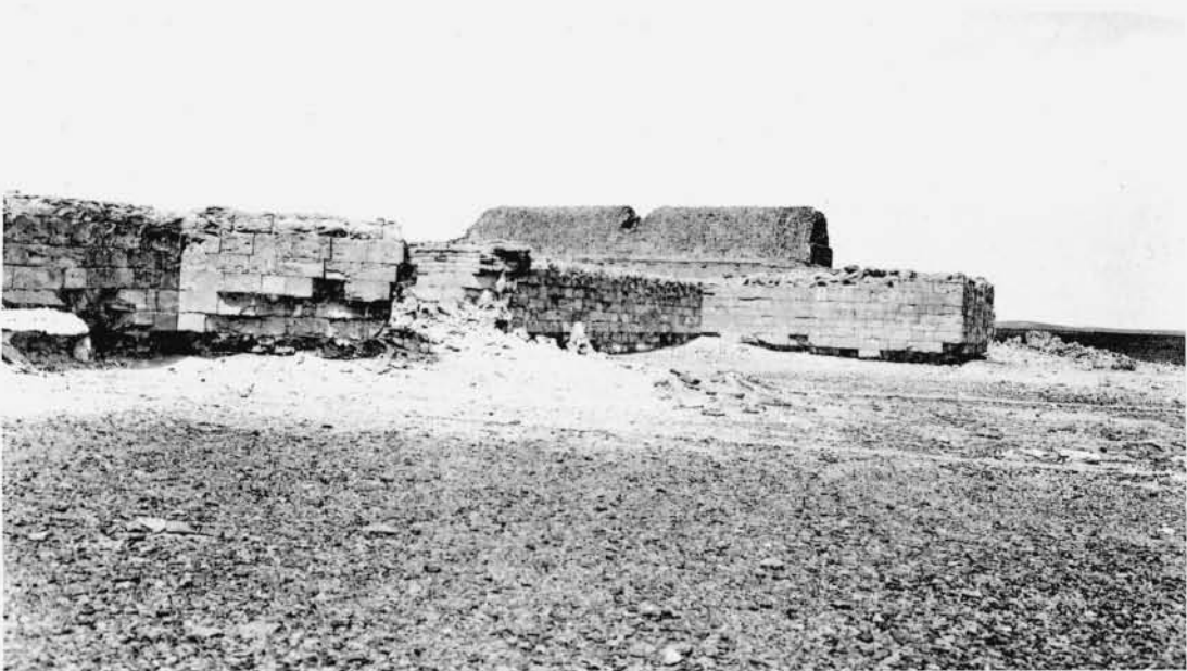
2. — QASR ET-TÛBA. - Extérieur de la chambre B' ; N.-E ; section enceinte Nord et grosse tour D.
