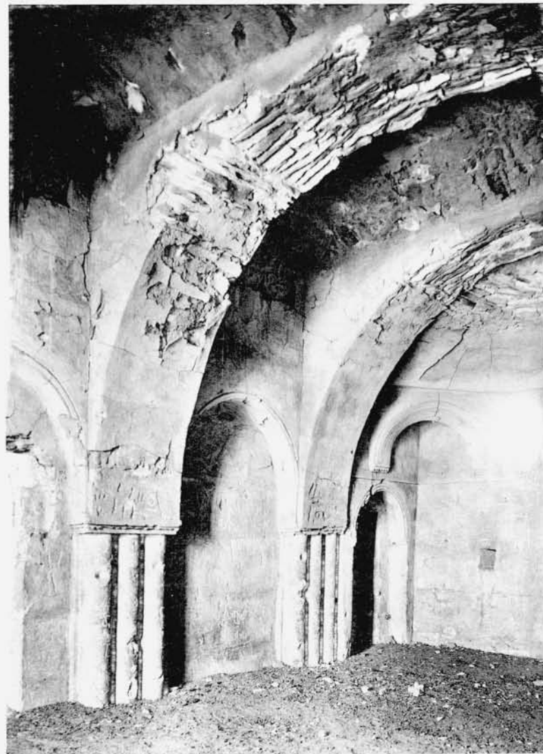
2. QASR-HARÂNEH. - Angle S.-O. de la salle 51. - Structure des grands arceaux.
