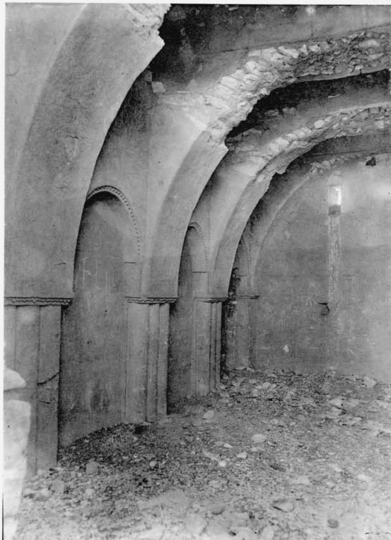
3. — QASR-HARÂNEH. - Intérieur de la salle 29, paroi orientale.
