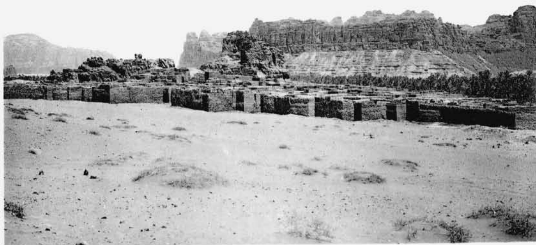
1. — EL-'ELA. Du côté du désert, le village est protégé par une enceinte continue.
