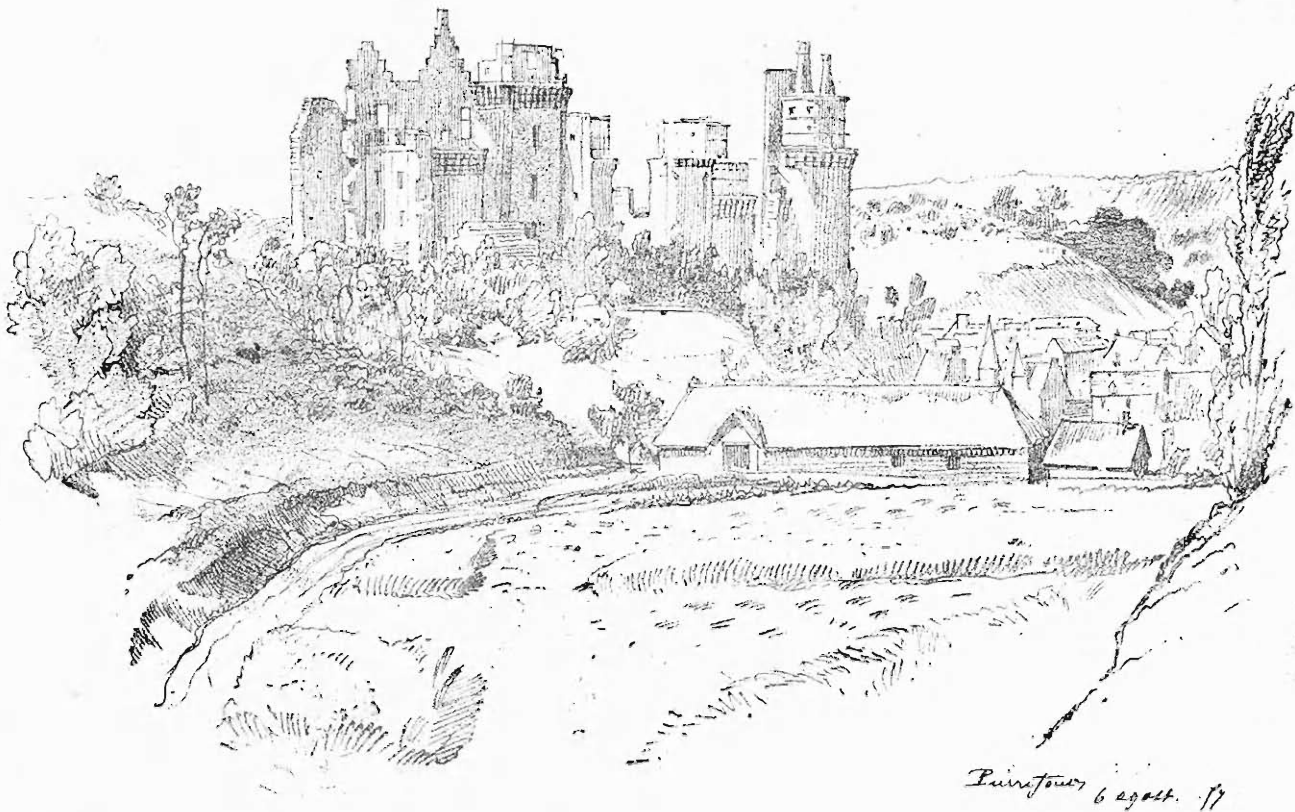
Fig. 58. — État du Château de Pierrefonds avant la restauration. — Fac-similé d'un croquis de Viollet-le-Duc (6 août 1857).
