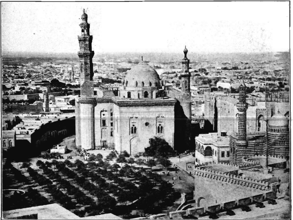
Le Caire vu de la citadelle. Façade méridionale de la mosquée du sultan Hassan.
