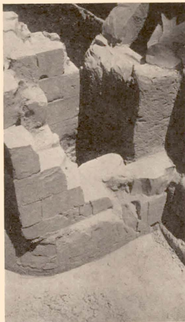
FIG. 2. — Contrefort et tourelle sur la face amont du barrage Harbaqa.
