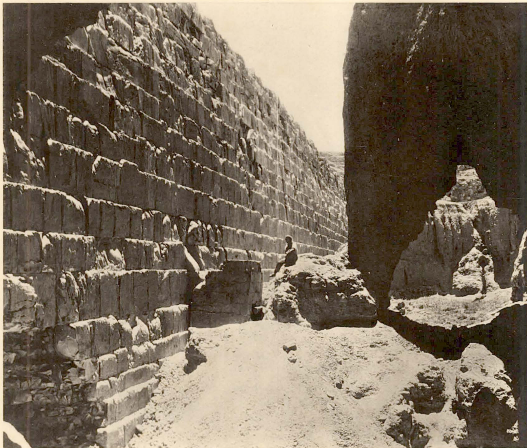
2. Face amont du barrage. Au centre, vanne et tourelle. A droite, falaise de sédiment.
