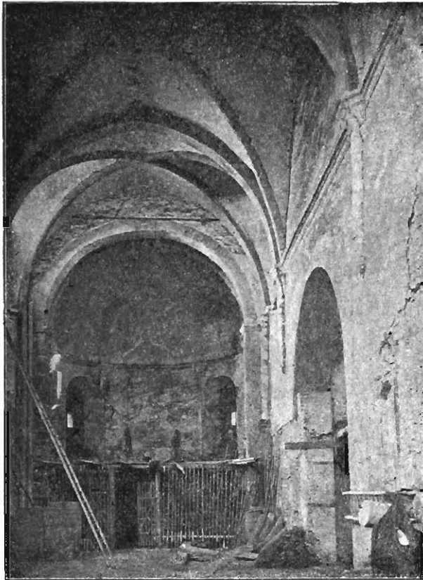
Fig. 20. Innere Ansicht im gegenwärtigen Zustande.
