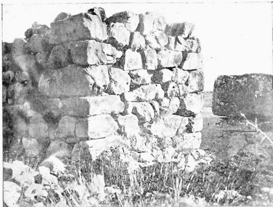
Fig. 3. Tirinto. — Assise orizzontali negli angoli sporgenti del bastione N-E.
