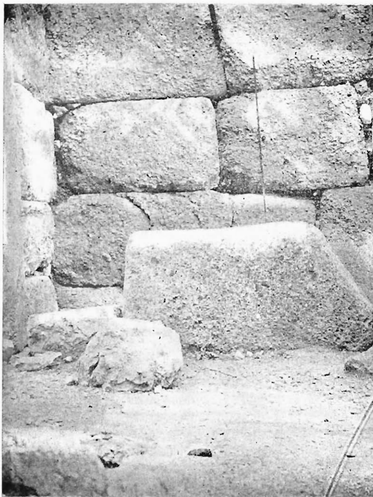
Fig. 15. Micene. — Porta dei Leoni. Apparecchio a massi parallelepipedi e corsi continui.
