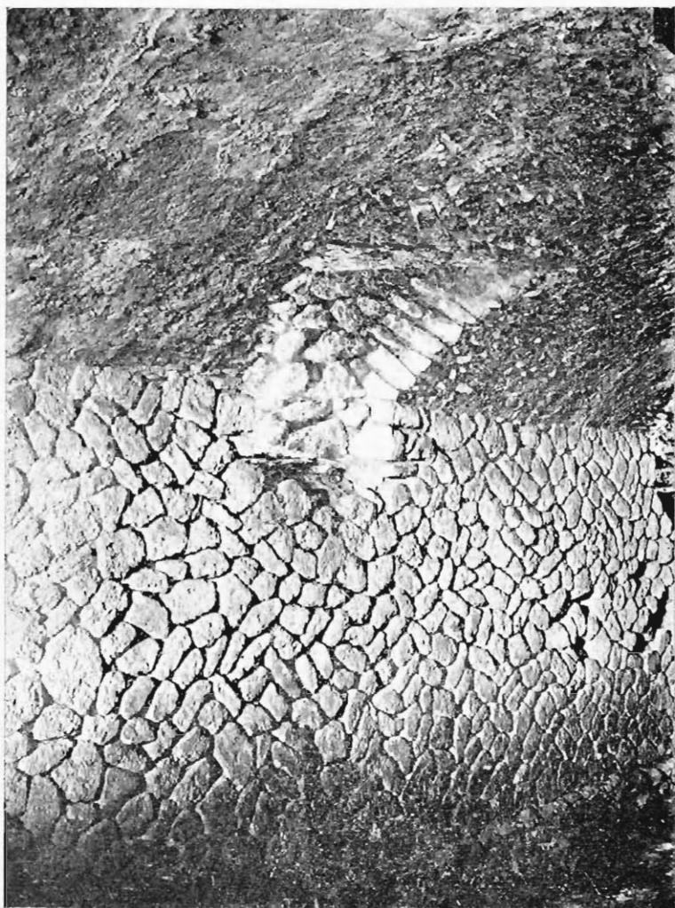
Fig. 12. Grotte di Torri. — Volta e parete del cripto-portico rivestite d'opera incerta. Strombo d'una feritoia.
