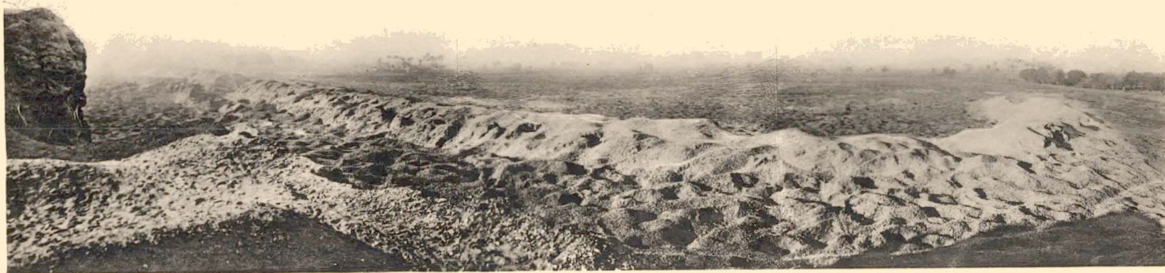
1. L'ensemble du rempart vu de la Citadelle à l'aurore.
