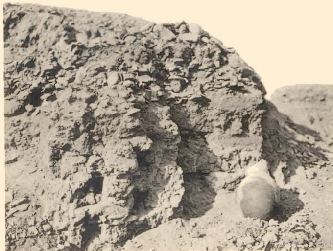
3. Mur de briques crues dans le même ouvrage.
