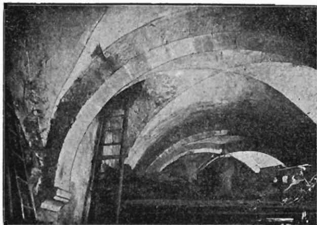
Fig. 80. Die Gewölbe der Sakristei und Marienkapelle.
