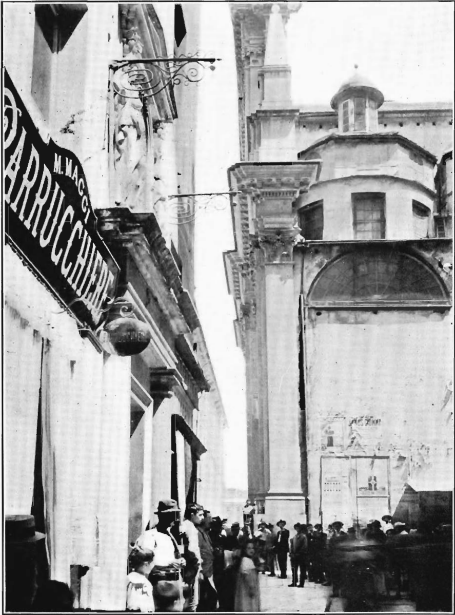
FIG. 3. THE LEANING FAÇADE OF S. AMBROGIO, GENOA.
