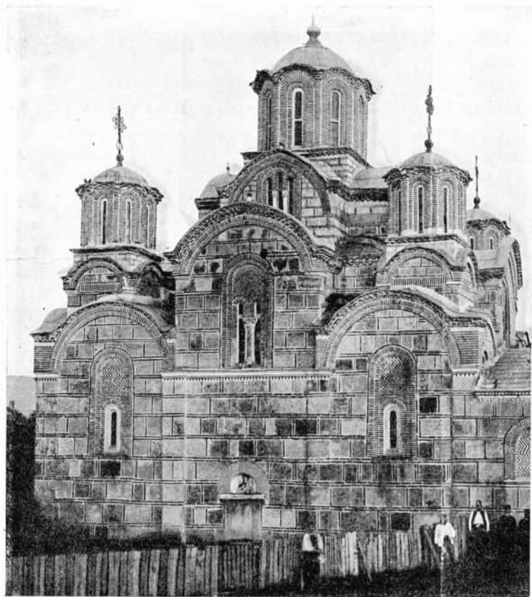
FIG. 74. — Église de Gračanica en Vieille Serbie. Façade Nord.
