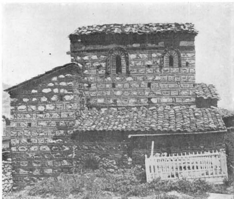
FIG. 10. — Basilique de Saint-Étienne à Castoria. Façade Sud.
