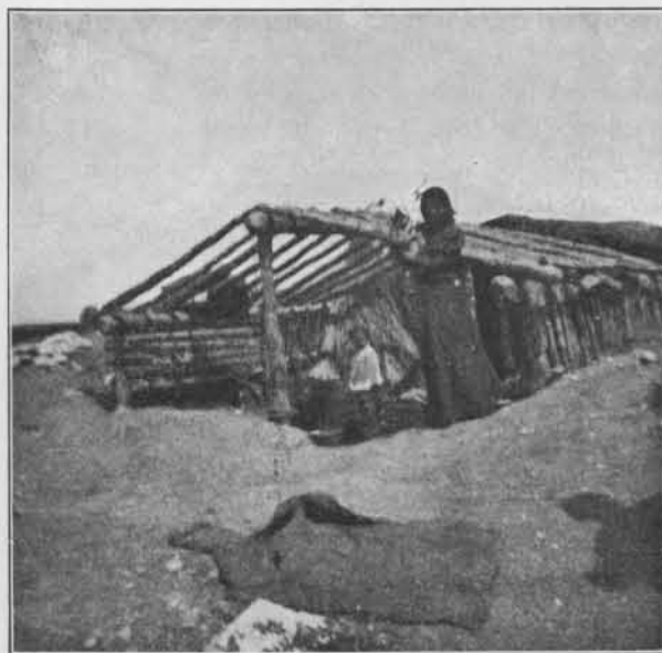
Fig. 8. Kolonistenhaus im Bau in Caraja.
