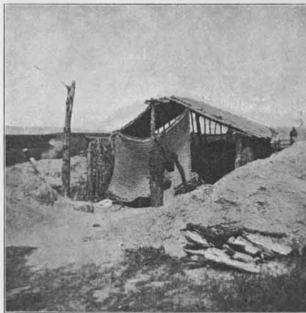
Fig. 2. Unfertige Grubenhütte der Kolonisten von Caraja.
