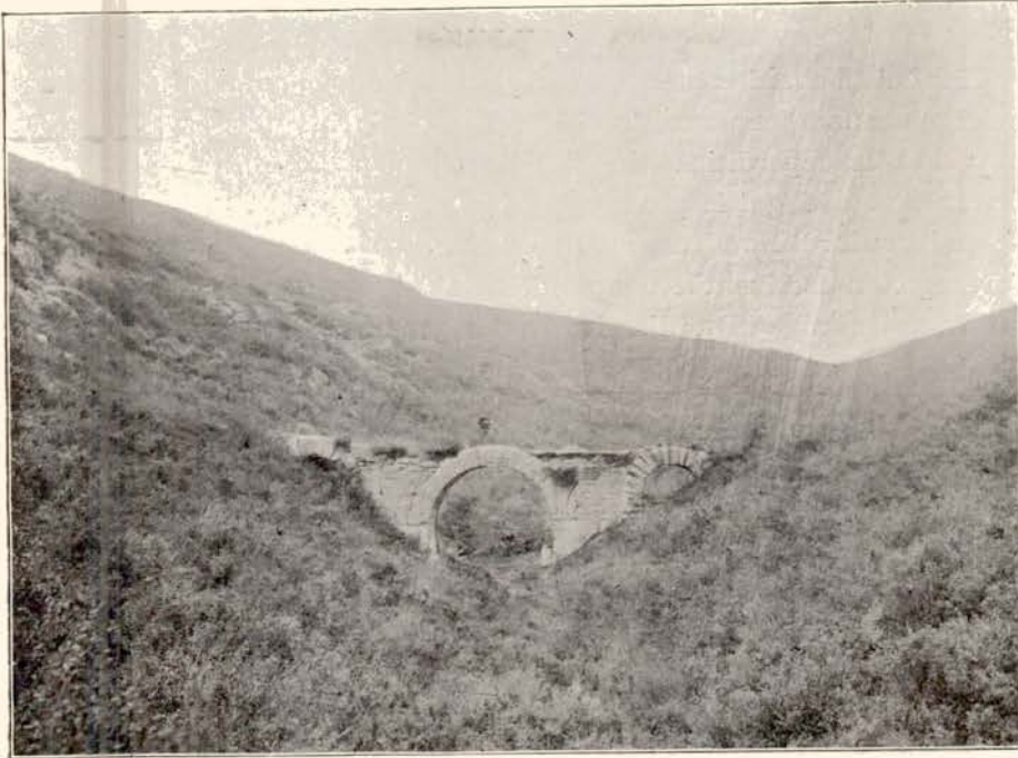
Aqueduc dans un ravin près Khamissa.
