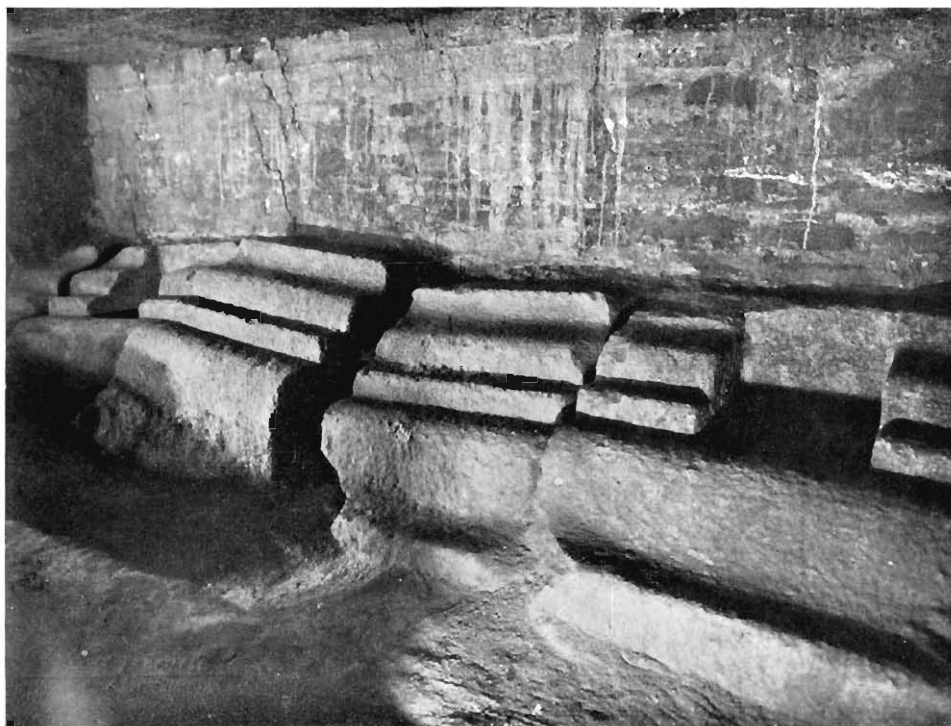
Fig. 25. — Altri massi sagomati come i precedenti, nella sottostruttura perimetrale del S. Aquilino.
