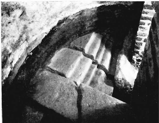
Fig. 24. — Massi sagomati nella sottostruttura della Cappella di S. Aquilino (in rispondenza della nicchia nella quale è ora il sarcofago detto di Galla Placidia).
