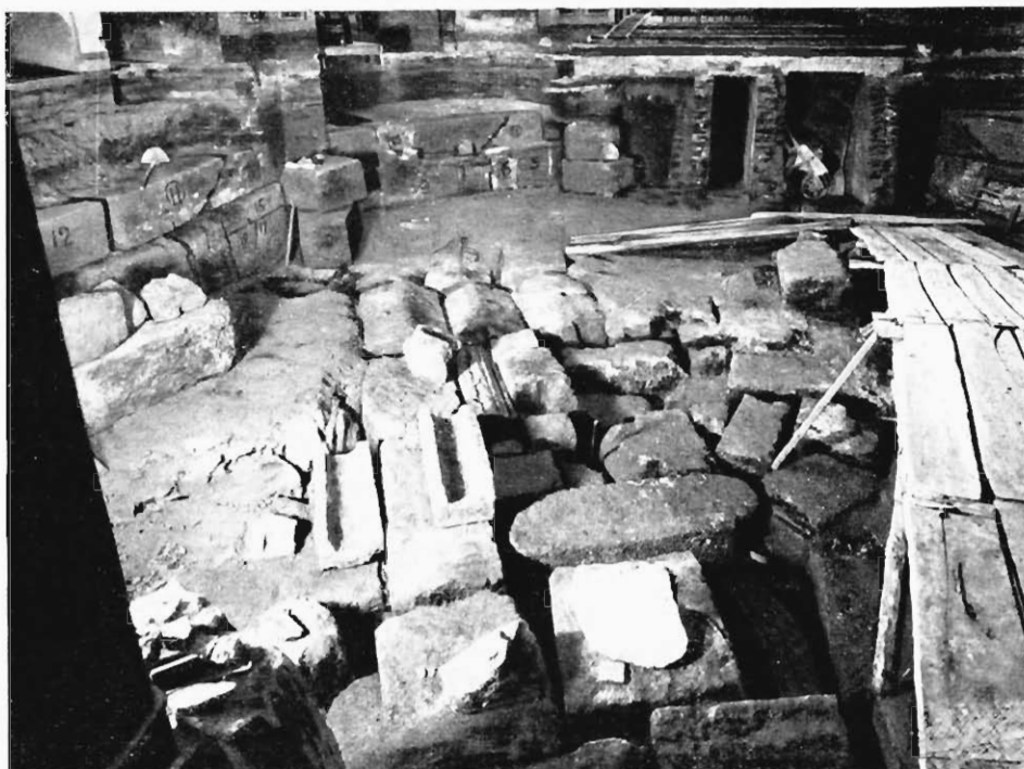
Fig. 10. — Come si presenta costituita la grande platea del S. Aquilino.
