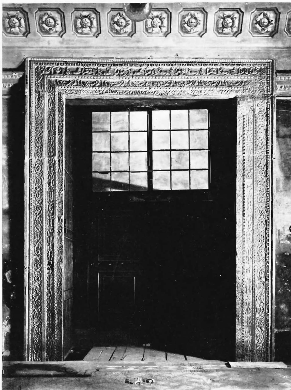
Fig. 2. — Porta romana all'ingresso della Cappella di S. Aquilino.
