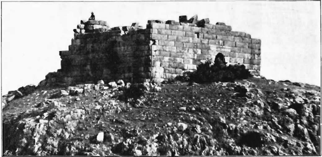
Fig. 5. Der Paulusturm, aus Südost gesehen.
