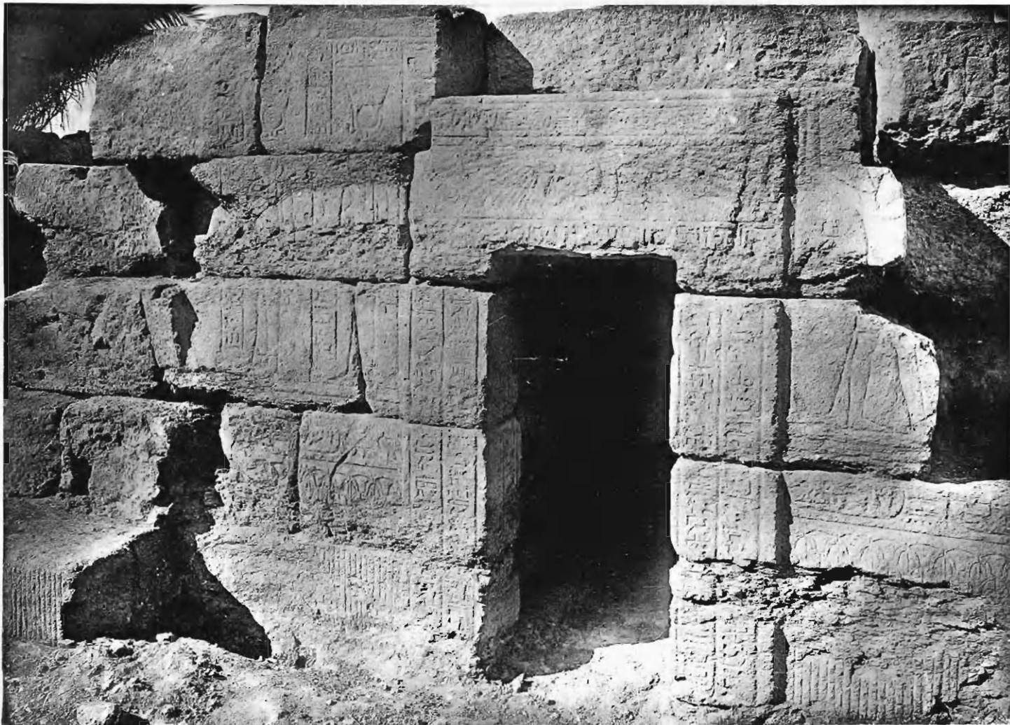
Porte du Mur Extérieur Est.
