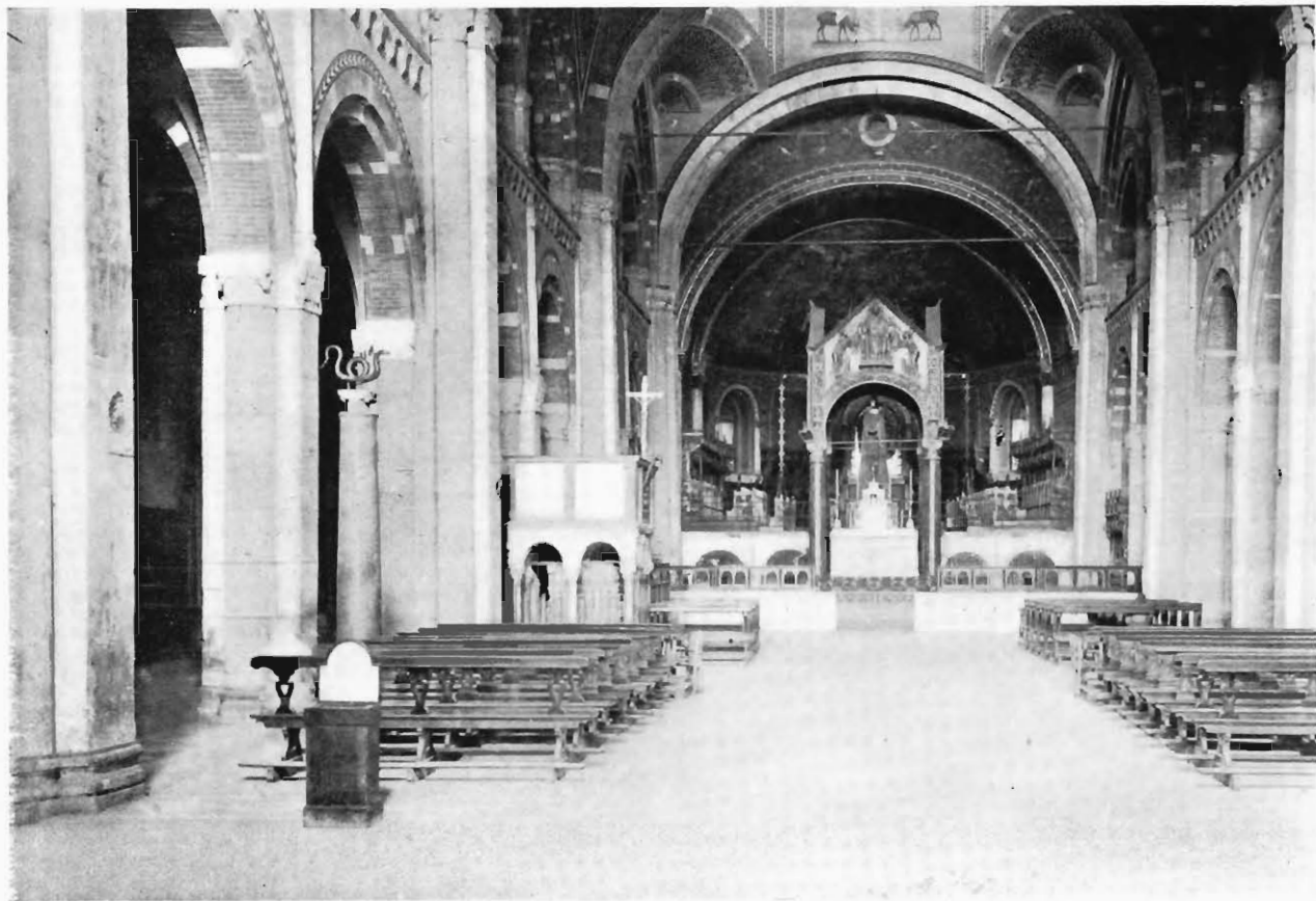
FIG. 12. S. AMBROGIO, MILAN. THE NAVE.
