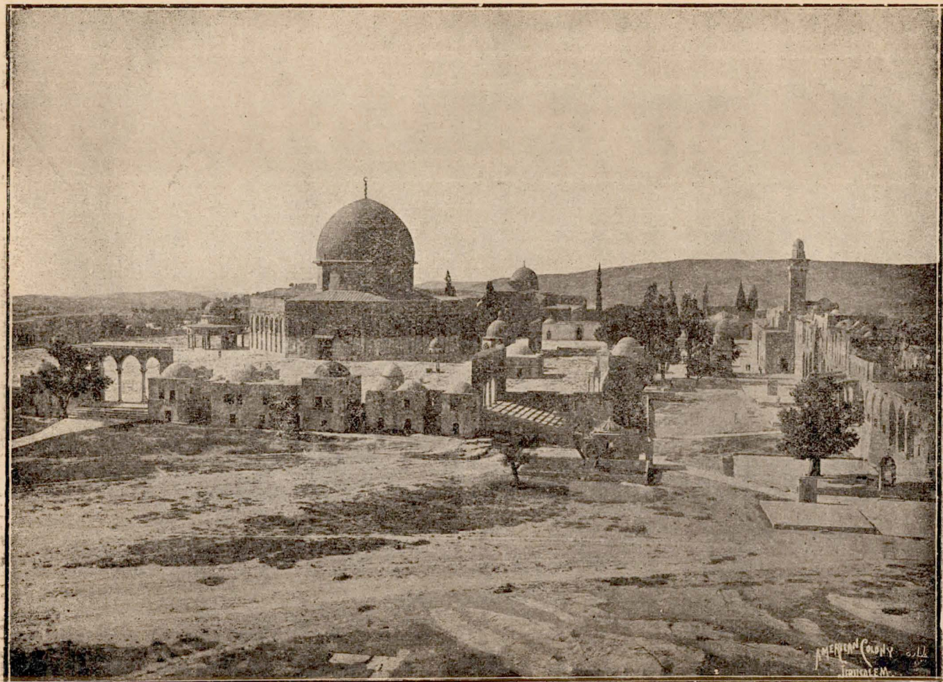
Fig. 1 — Vue de l'Enceinte de Haram de Pangle ( Nord-Ouest )
