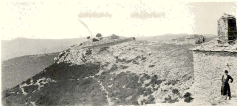
A. — SITE DE L'ANCIENNE FORTERESSE DE KASTRO.
