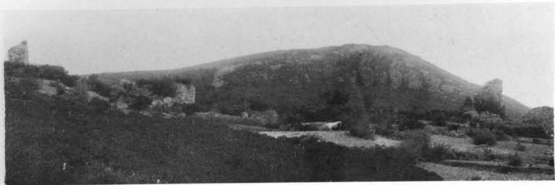
BOUGIE. Ruines de l'Enceinte Hammadite.
