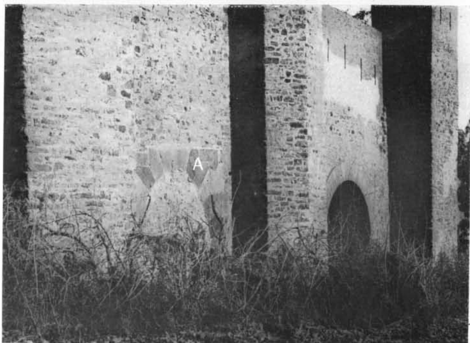
BOUGIE. Porte de Fouka. (Côté de la Campagne) A, ancienne porte murée.
