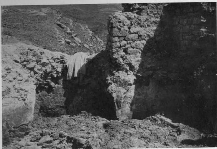
FIG. 23. — Partie de la gaine qui entourait la coupole centrale. Côté Nord. (Commencement des fouilles.)
