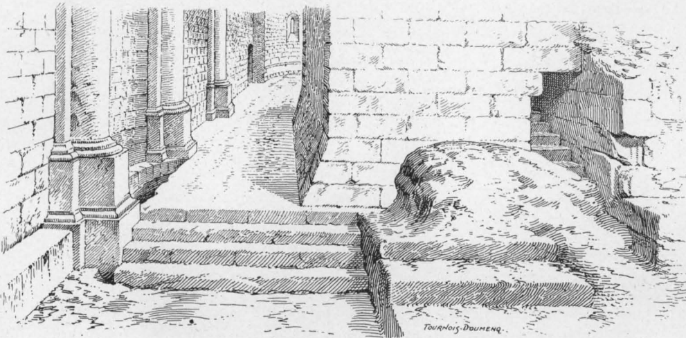
Fig. 58. — Monument supérieur : partie au-dessus de la grotte.
