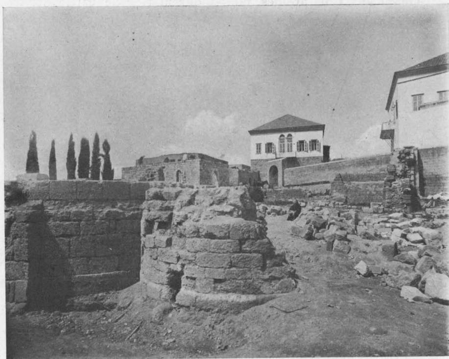
Fig. 68. — Chevet extérieur : partie Nord.
