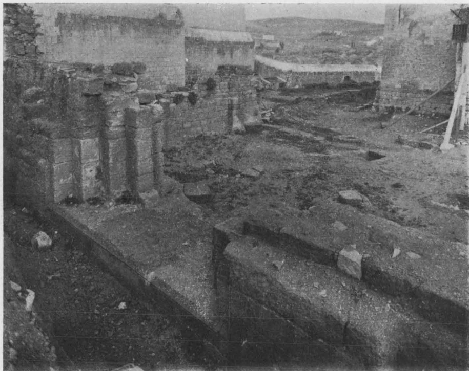
Fig. 66. — Façade et portail.
