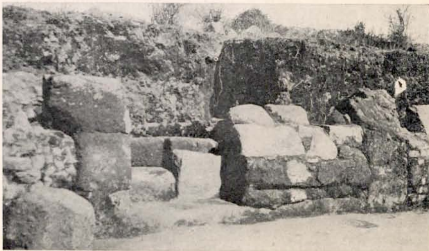
Fig. 4. - Porta B con la muratura in parte demolita.
