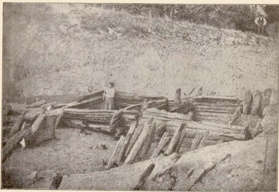
Fig. 90. Substructions en madriers à l'intérieur du rempart de la terramare de Castione. Loc. cit.
