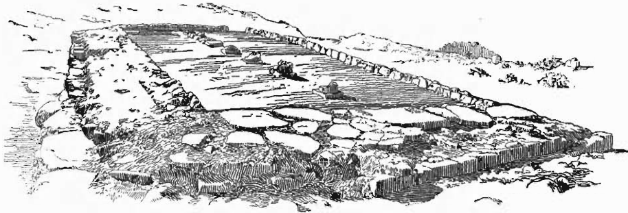
Abb. 54. Ansicht des Tempelfundaments von Norden her.
