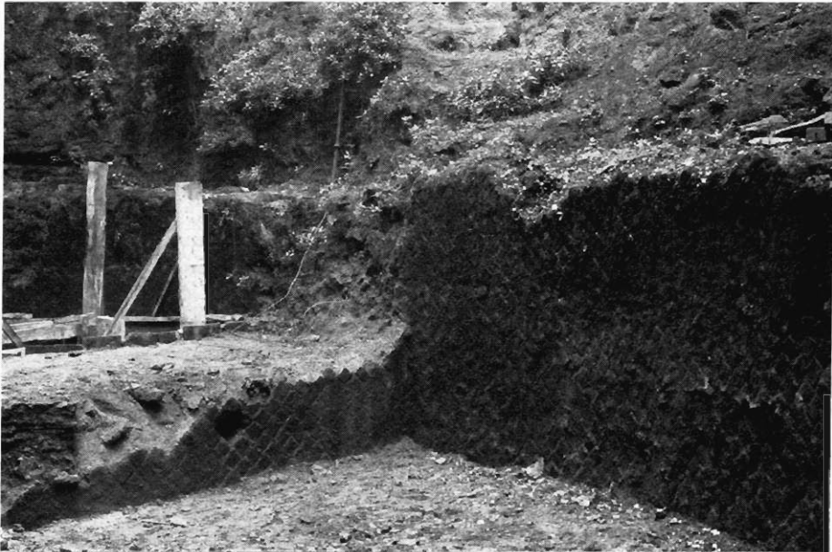
Abb. 20. Augusteum. Apsis mit Zungenmauer
