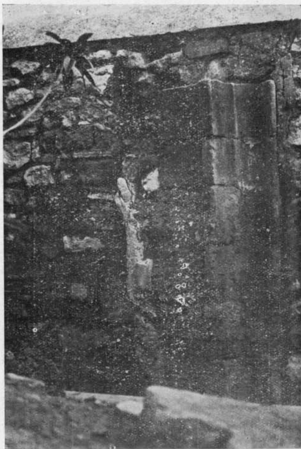
Nervures d'une porte de l'église de l'Observance restant encore dans le jardin des Thermes.
