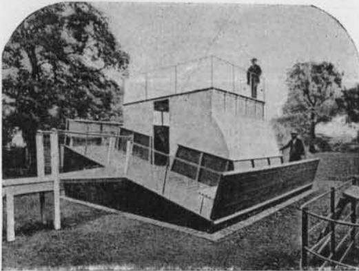
Fig. 29. — Dispositif expérimental pour l'étude du bateau antimal de mer.
