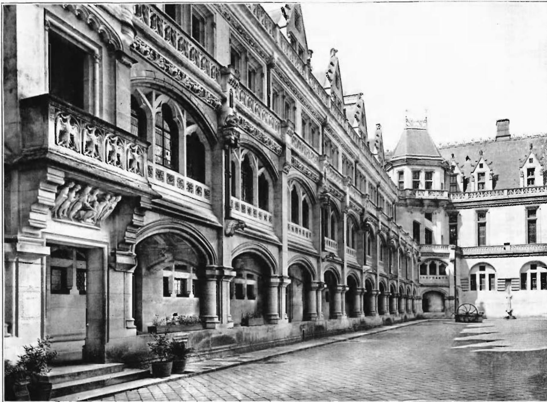
VUE INTÉRIEURE DE LA COUR PRISE DE LA PORTE D'ENTRÉE (PORTIQUE ET GALERIE DE SURVEILLANCE DES GARNISONS MERCENAIRES)
