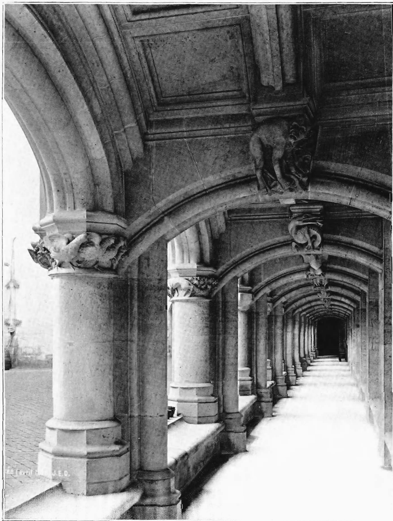
VUE INTÉRIEURE DU PORTIQUE DU REZ-DE-CHAUSÉE
