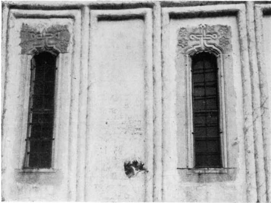
Fig. 52. — Eglise de Golești; fenêtres
