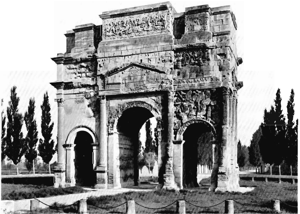
Tav. 408. - In alto : Saint-Rémy, mausoleo dei Giuli e arco trionfale. Età augustea. - In basso : Orange, arco trionfale. Età augustea.
