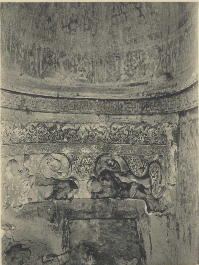
Fig. 2. — Intérieur du Mihrab.
