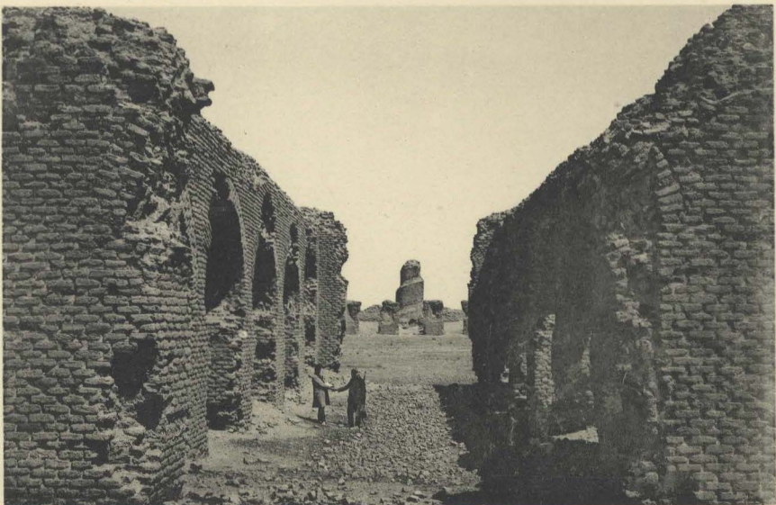
Fig. 5. - Aboudolaf. Travée centrale.
