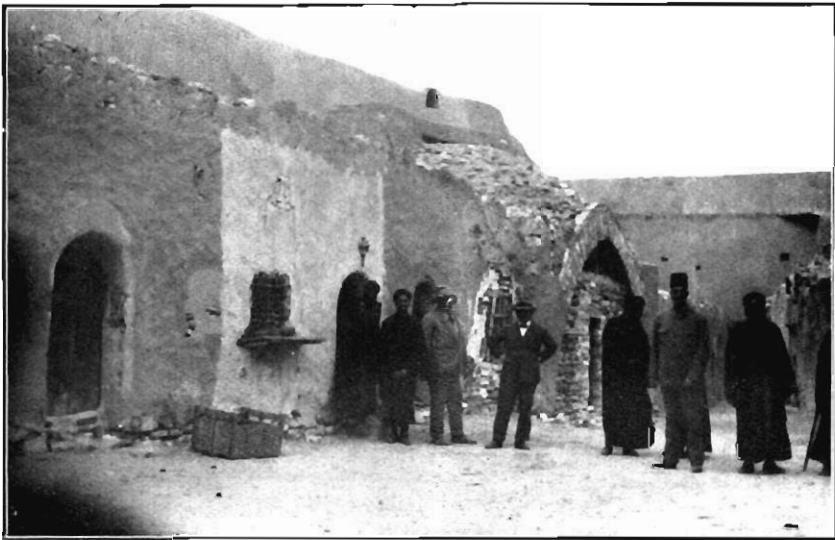
Entrée des cellules à Deir Anba Bishay.
