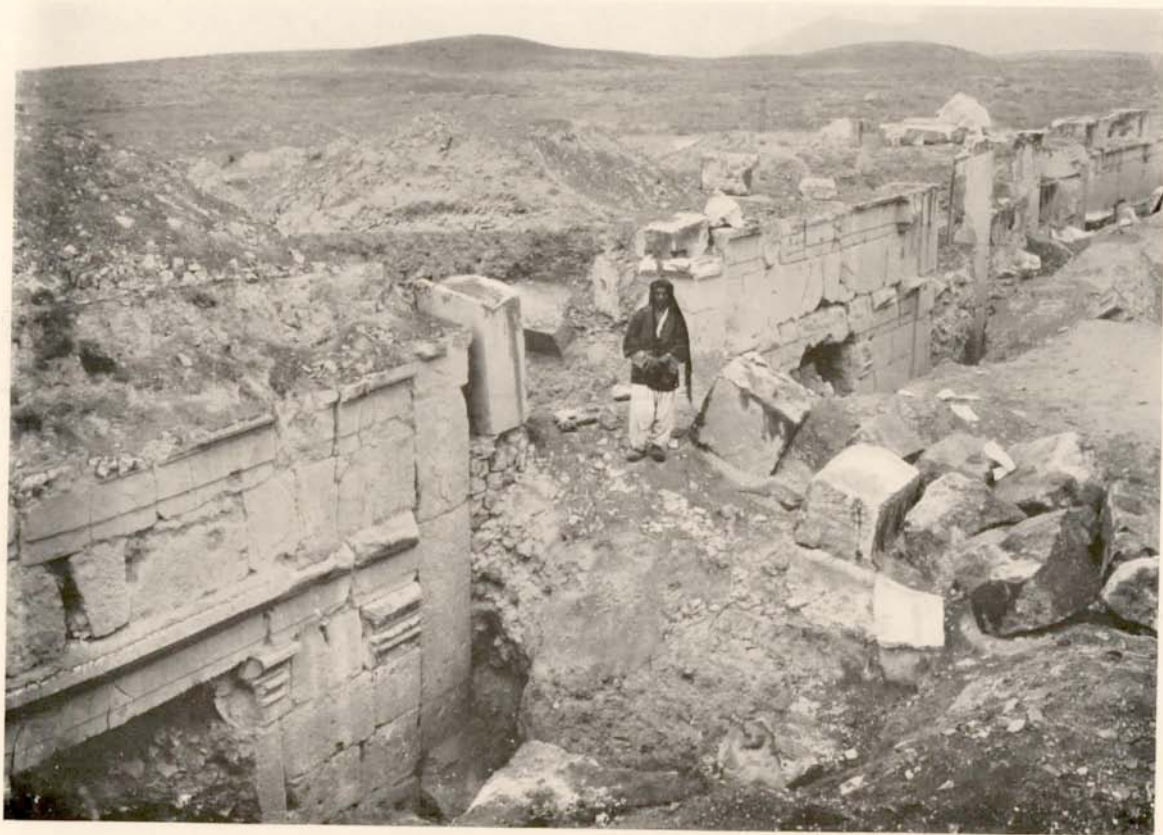
Découverte du mur de fond du portique, reconstitué aux Musées Royaux d'Art et d'Histoire. Avant les travaux, aucune trace du mur n'apparaissait à la surface du sol.
